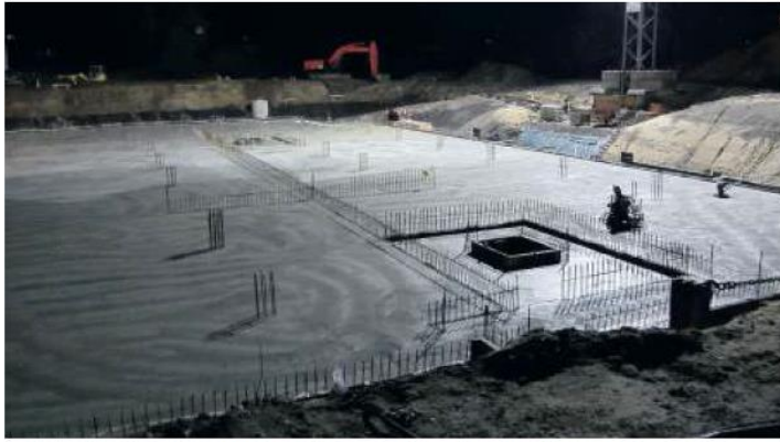
An der 2000 Quadratmeter großen Sohlplatte der Tiefgarage im Lindenhof wurde nachts gearbeitet.
